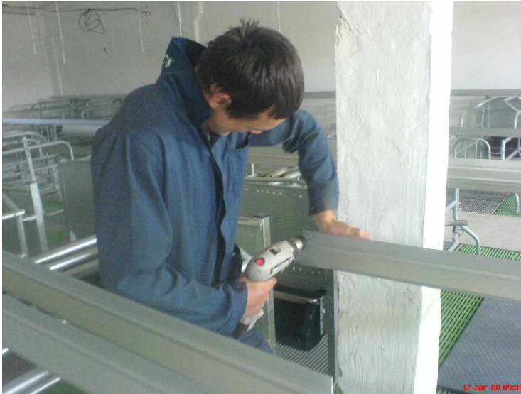
Рис. 1. Студенты специальности 260601 – «Машины и аппараты пищевых производств» осуществляют монтаж комплекса по откорму сельскохозяйственных животных
